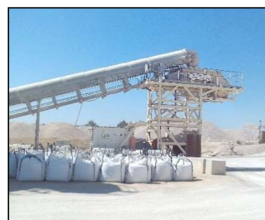
Convoyeur et poste de chargement
